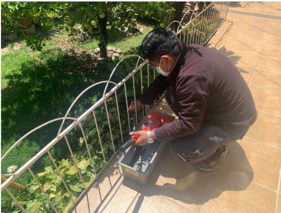
PRUEBA HIDRÁULICA EN LA ACOMETIDA
