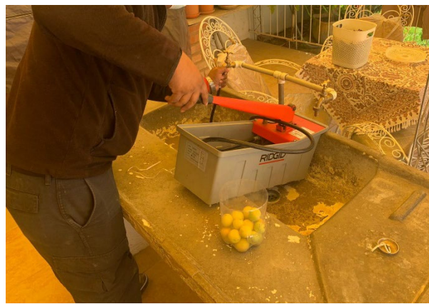
PRUEBA HIDRÁULICA EN EL ÁREA DEL PATIO
